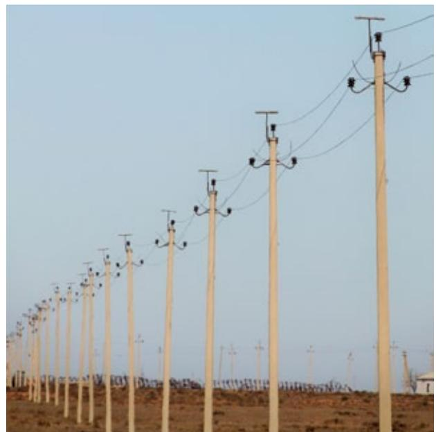
Рис. 2. ЛЭП-убийца птиц, оснащённая металлическими «усами» и «присадами», запрещёнными к установке. Фото автора.
