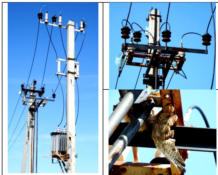
Рис. 1 – Птицепоопасные элементы ВЛЗ 10 кВ (РЛНД, МТП, ОПН) и хищная птица - и сокол (пустельга обыкновенная), погибшая от электрошока на разъединителе РЛНД-10
