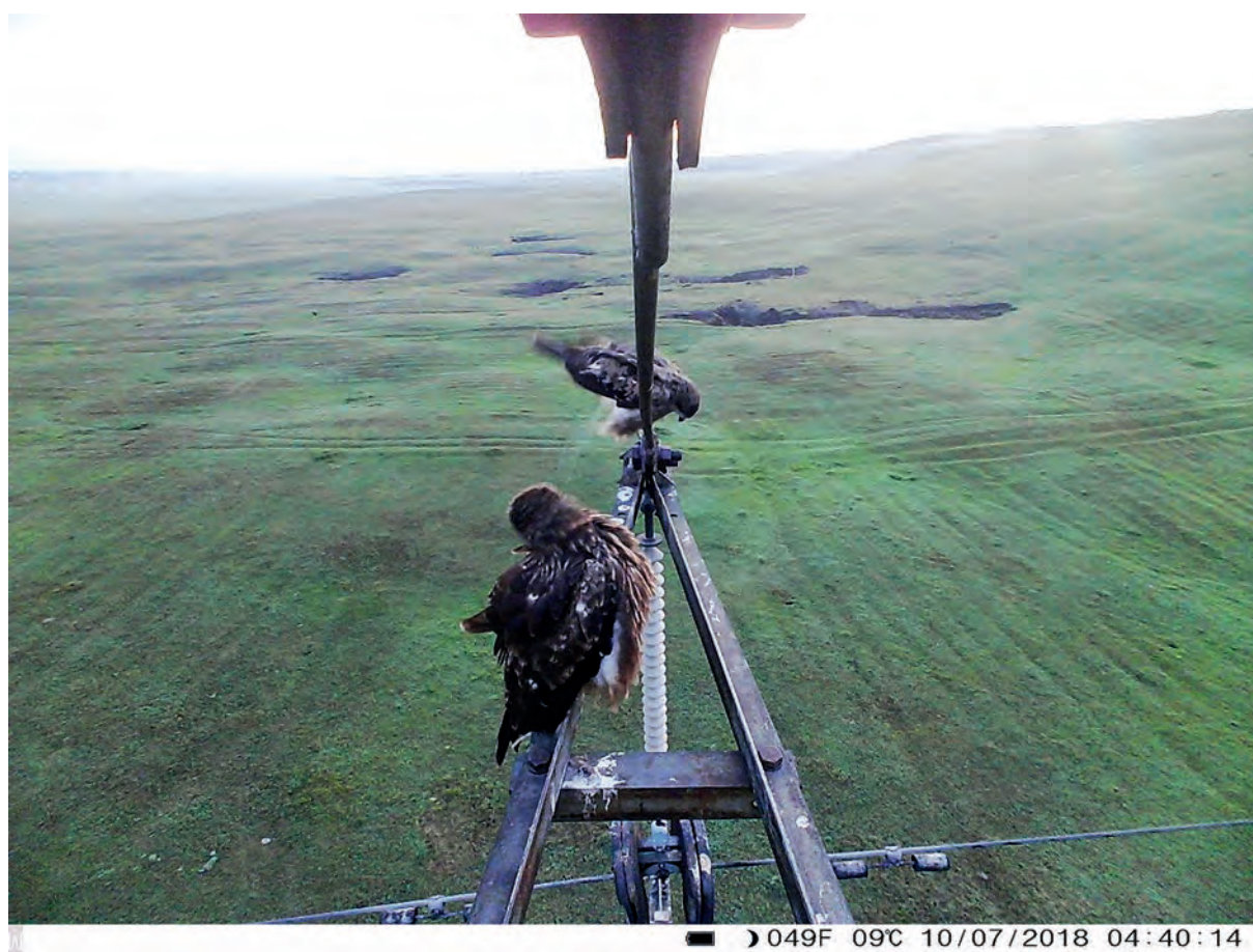
Рис. 6. Дефекация молодого коршуна на провода опоры ЛЭП.
